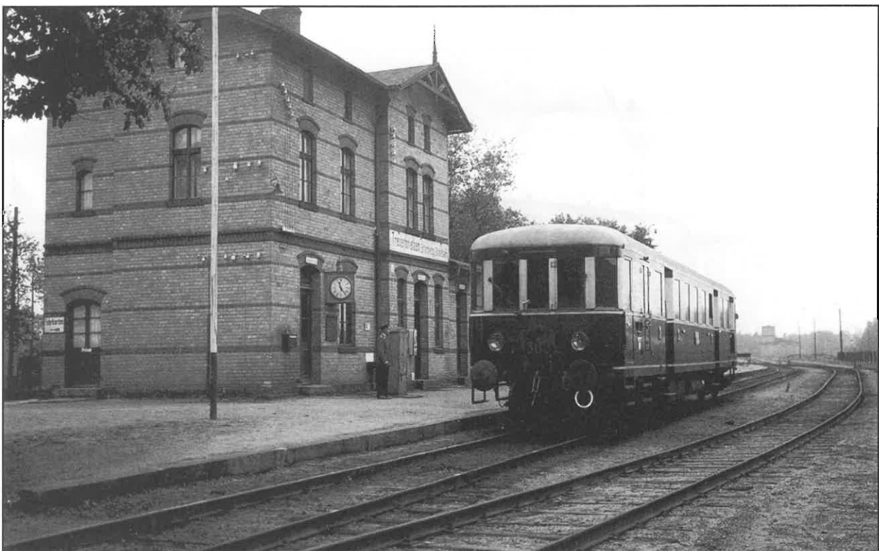
Der Triebwagen 302 in Treuenbrietzen um das Jahr 1930. Die Empfangsgebäude waren in Typen klassifiziert, dieses hier entsprach dem Typ 1
